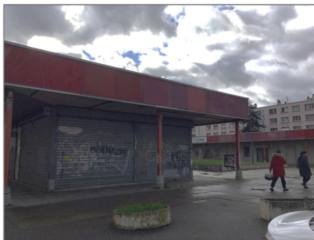
▲ Un commerce qui a fermé ses portes, QPV Les Brosses, Crédit photo MRIE, 2023
