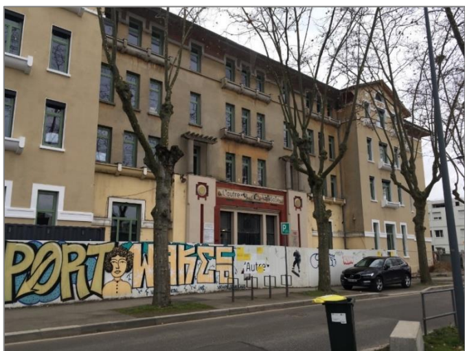
▲ L'autre soie, travaux en cours dans le bâtiment de l'ancien IUFM. Crédit photo MRIE, 2023
